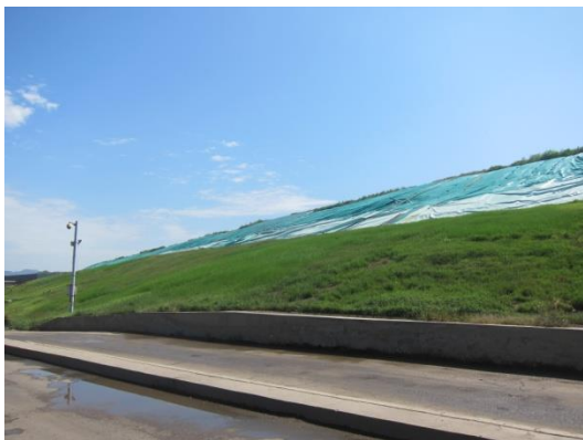
阿苏卫垃圾卫生填埋场现状照片
